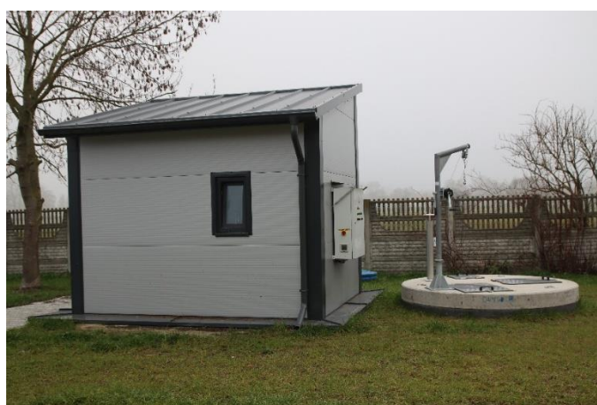
budynek kraty schodkowej i pompownia główna
