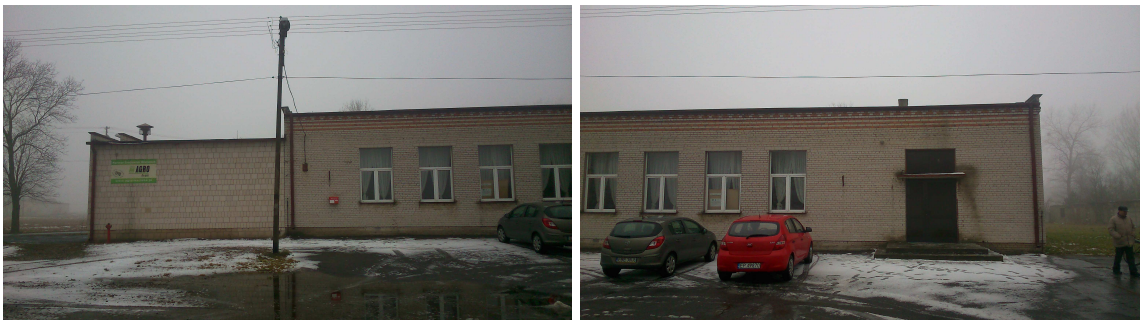
Fot. 1 i 2 – Elewacja południowo-wschodnia.
