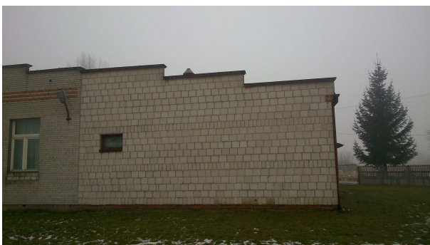
Fot. 4 – Elewacja północno-wschodnia.
