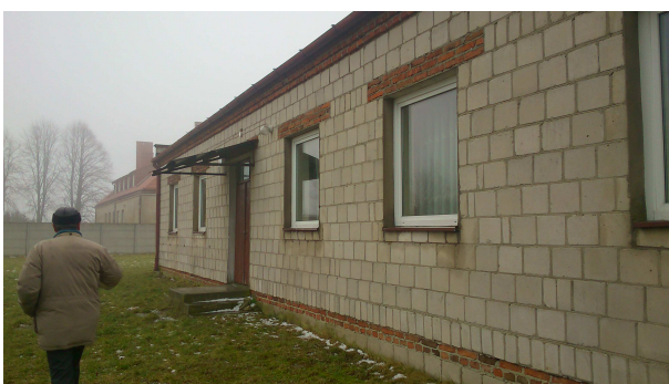
Fot. 3 – Elewacja północno-zachodnia.
