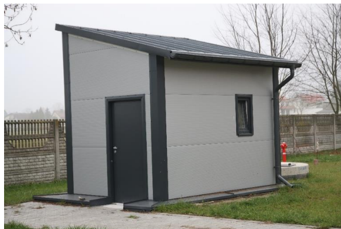
budynek mechanicznego oczyszczania ścieków (z kratą schodkową)
