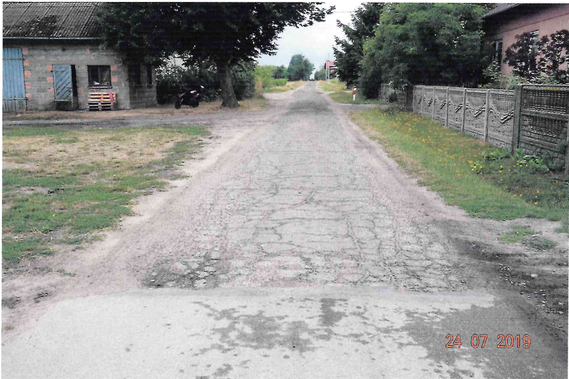
Nr 4. Stan nawierzchni istniejącej w km 0+590
