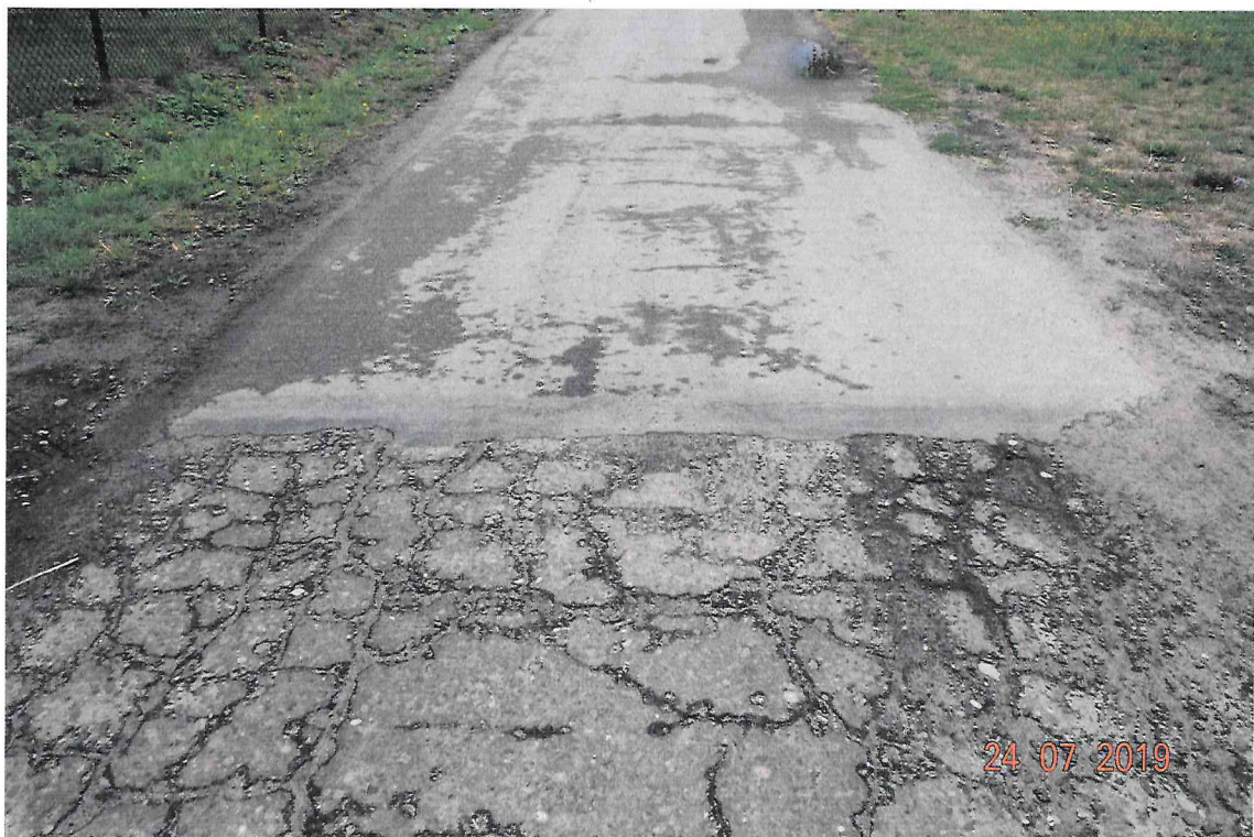
Nr 4. Stan nawierzchni istniejącej w km 0+590
