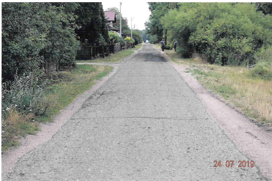
Nr 2. Widok na środkowy fragment odcinka drogi w kierunku wschodnim
