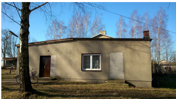
Fot. 4. Elewacja wschodnia.
