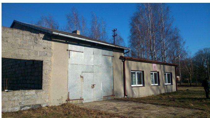
Fot. 1. Elewacja południowa.
