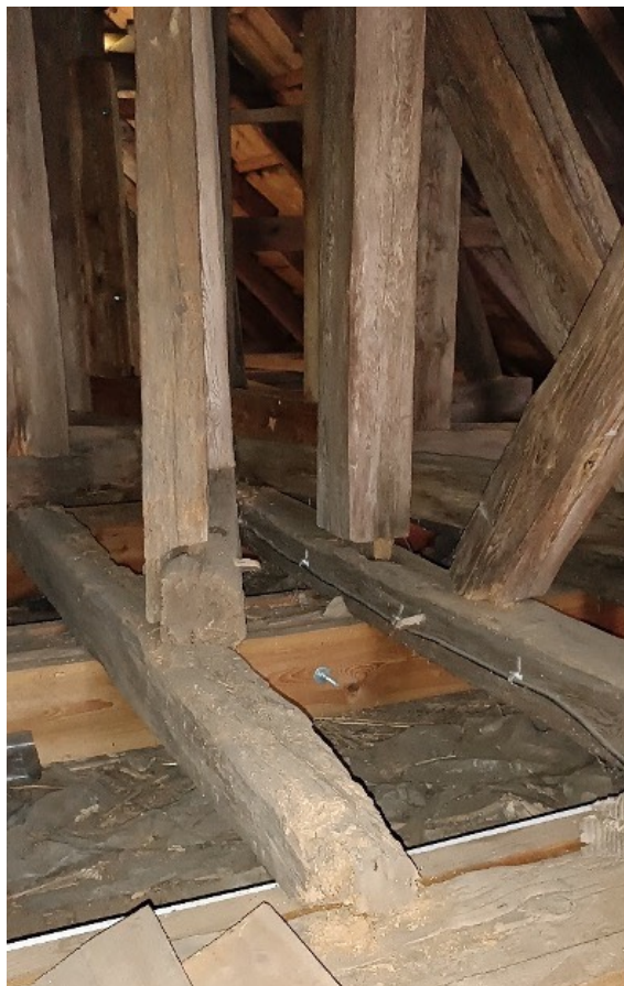
Rys 12. Widok na belki podwalinowe, zastrzały i słupki wieży
