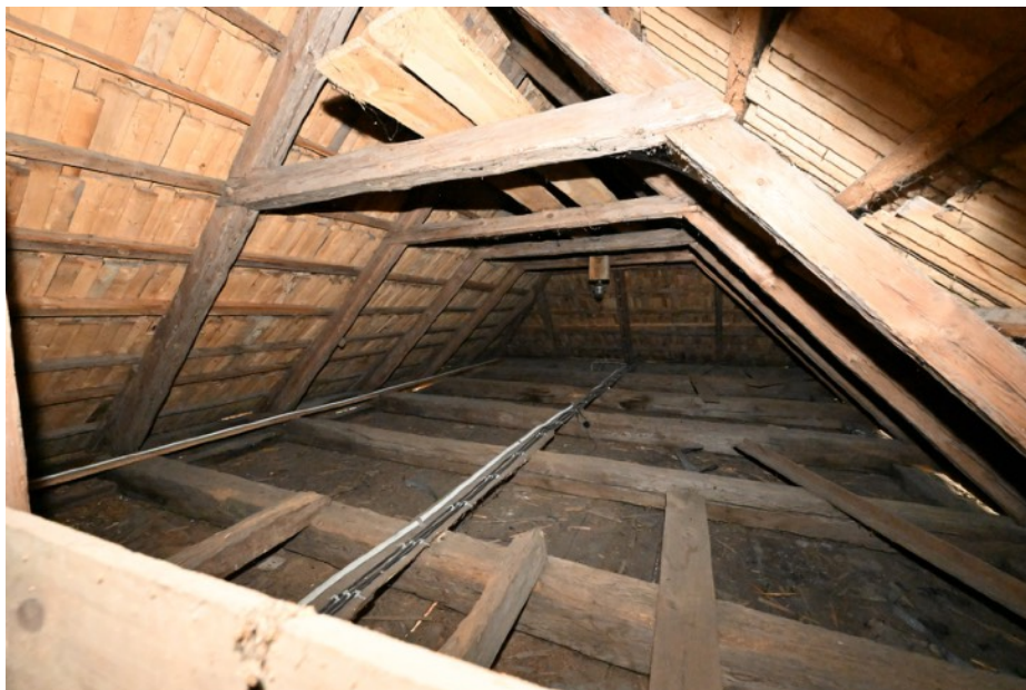
Rys 5. Widok na więźbę jętkową nad prezbiterium
