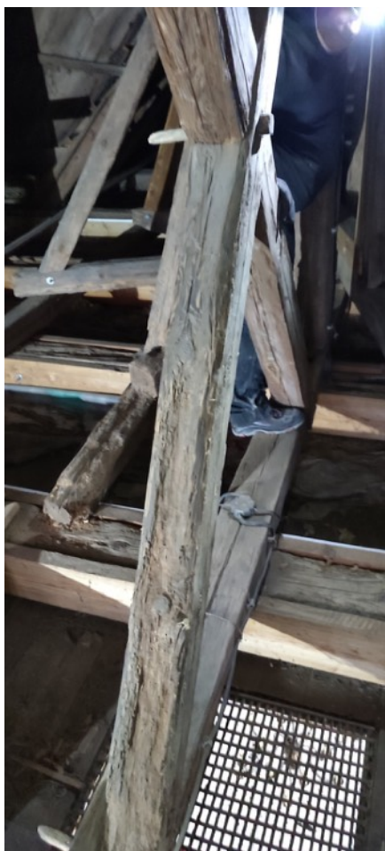
Rys 10. Degradacja elementów ramy storczykowej – rygla, podwaliny oraz zastrzałów
