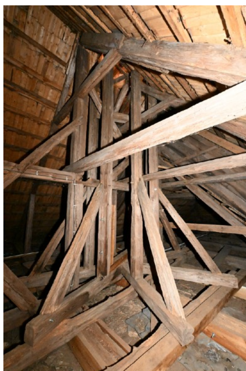
Rys 4. Konstrukcja sygnaturki
