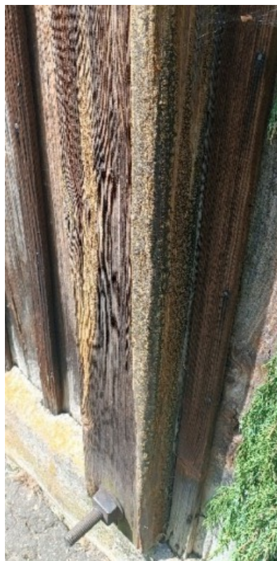
Rys 33. Glony na północnej elewacji kościoła
