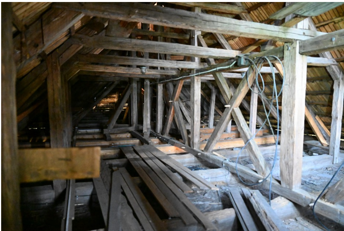
Rys 3. Widok na ramę storczykową więźby nad nawą
