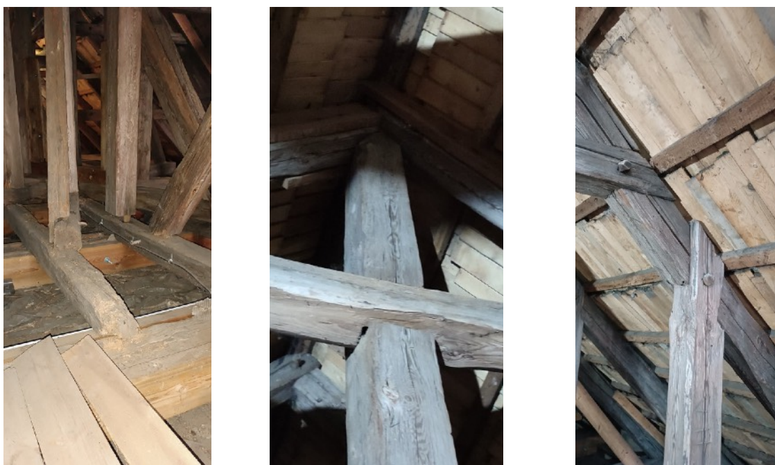
Rys 6. Połączenia w więźbie: a) na czop prosty, b) na wręb jednostronny, c) na jaskółczy ogon
