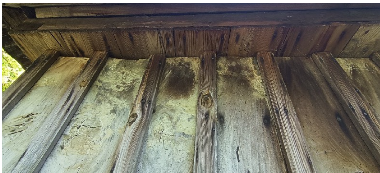
Rys 31. Grzyb domowy właściwy występujący w rejonie pod okapem na ścianie wschodniej
