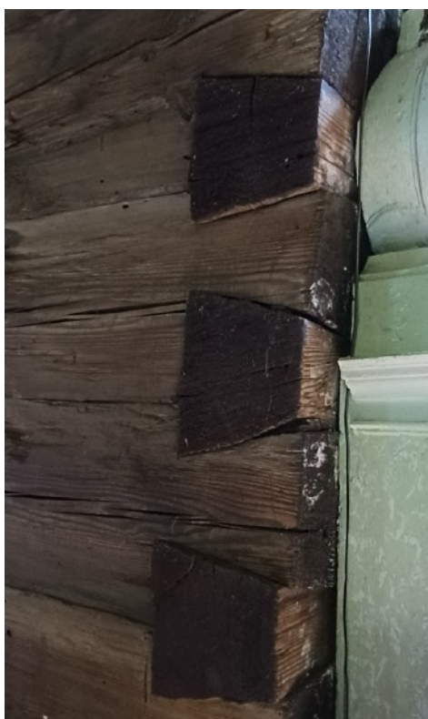
Rys 7. Łączenie belek w węglach (zdjęcie z lewej)
