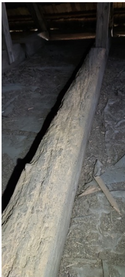
Rys 17. Ugięcie belek wiązarowych i desek stropowych – widok z chóru (zdjęcie górne z prawej)
