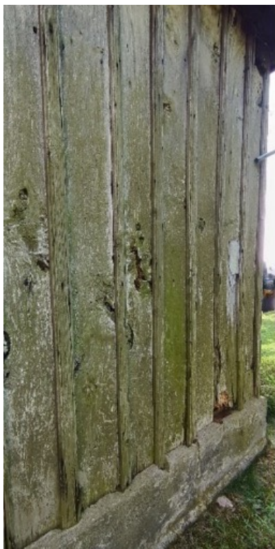
Rys 33. Glony na północnej elewacji kościoła
