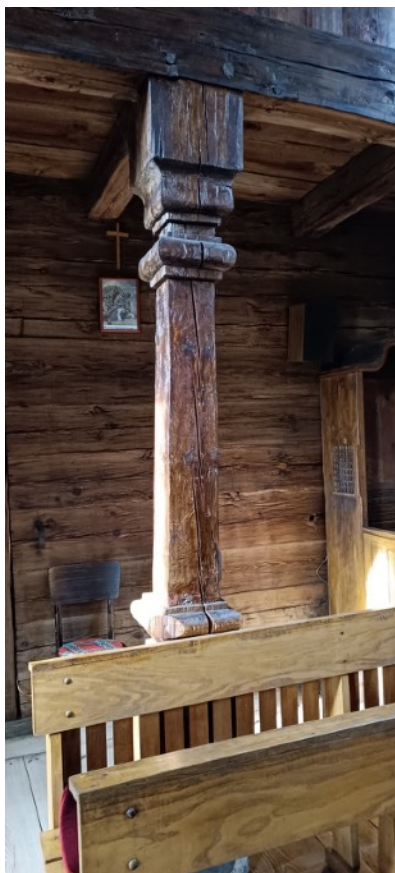
Rys 23. Pęknięcia skurczowe w słupie podpierającym chór (zdjęcie z lewej)
