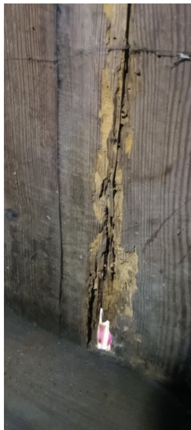
Rys 23. Pęknięcia skurczowe w słupie podpierającym chór (zdjęcie z lewej)
