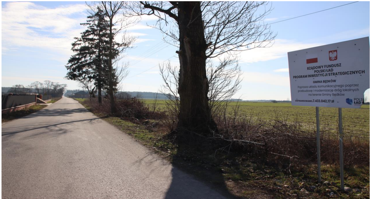
Fot. Droga w Ewcinie
