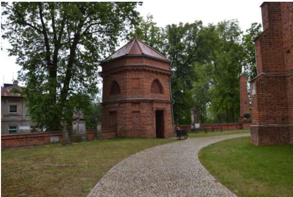
Zdjęcie 13. Dzwonnica przy Kościele pw. Narodzenia NMP, Cmentarz przykościelny. Źródło: opracowanie własne. Fot. Paulina Maćkowiak
